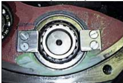
Epoxydharz-Kitt - Instandsetzung eines Getriebegehäuses
