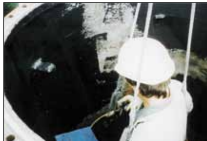
WEICON WR - Beschichtung einer CO 2 Reinigungsanlage
