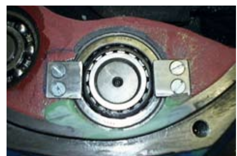
Instandsetzung eines Getriebegeh äuses Repair of a gearbox-casing
